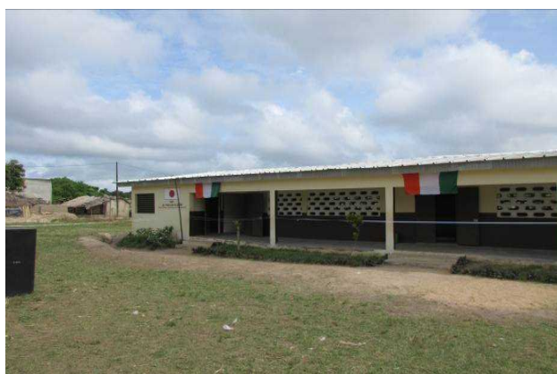
Le bâtiment de 3 classes construit à Boussoué
