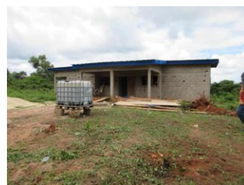
Construction de la maternité de Tankessé
