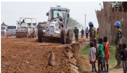
南スーダンのジュバにおいて道路整備を行う自衛隊の施設部隊 (写真提供: 防衛省)
