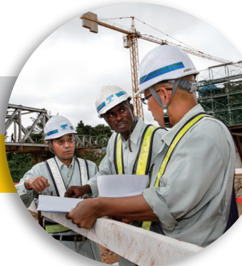
●ガーナにおける国道8号線の改修工事
